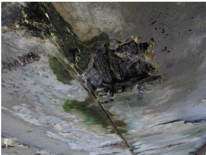
Odpadlá betonová krycí vrstva v podhledu pravého krajního nosníku se silně zkorodovanou betonářskou výztuží.
