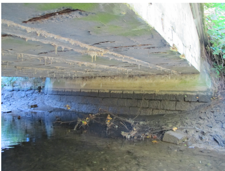
Pohled na opěru O1 včetně křídel. Patrné na povodním křídle zpevnění z vlepené betonářské výztuže, v místě zpevnění lokální stopy po zatékání a uvolněné spárování.
