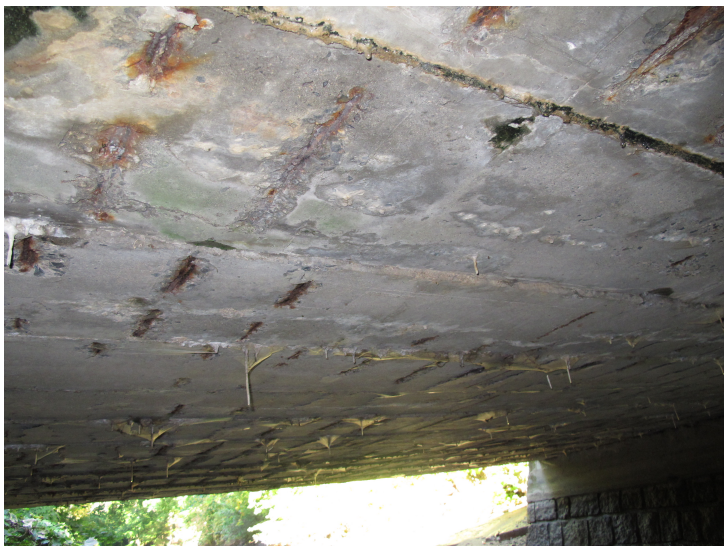
Podhled nosné konstrukce, propisující se betonářská výztuž – nedostatečná krycí vrstva. Stopy po zatékání v celém podhledu NK s výluhy pojiva a četnými krápníky.
