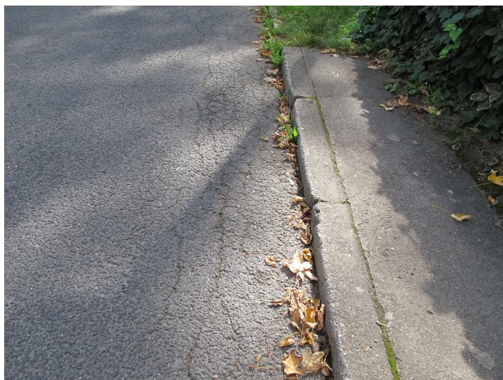
Četné síťové trhliny ve vozovce podél levé římsy.
