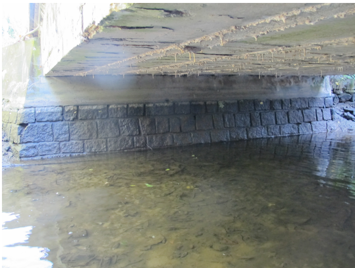
Pohled na opěru O2. Uchycená vegetace za křídlem.
