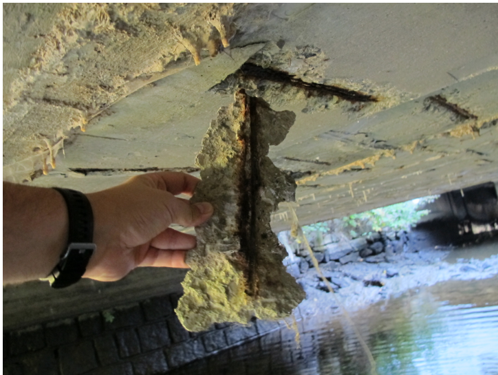
Nedostatečná betonová krycí vrstva oddělitelná pouhou rukou na celé ploše podhledu nosné konstrukce.
