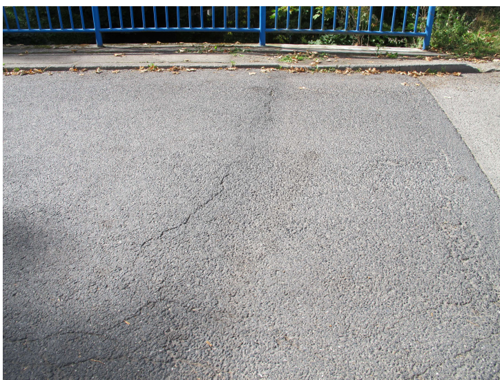
Příčná trhлина a propadlá vozovka v místě konce nosné konstrukce za opěrou O2.
